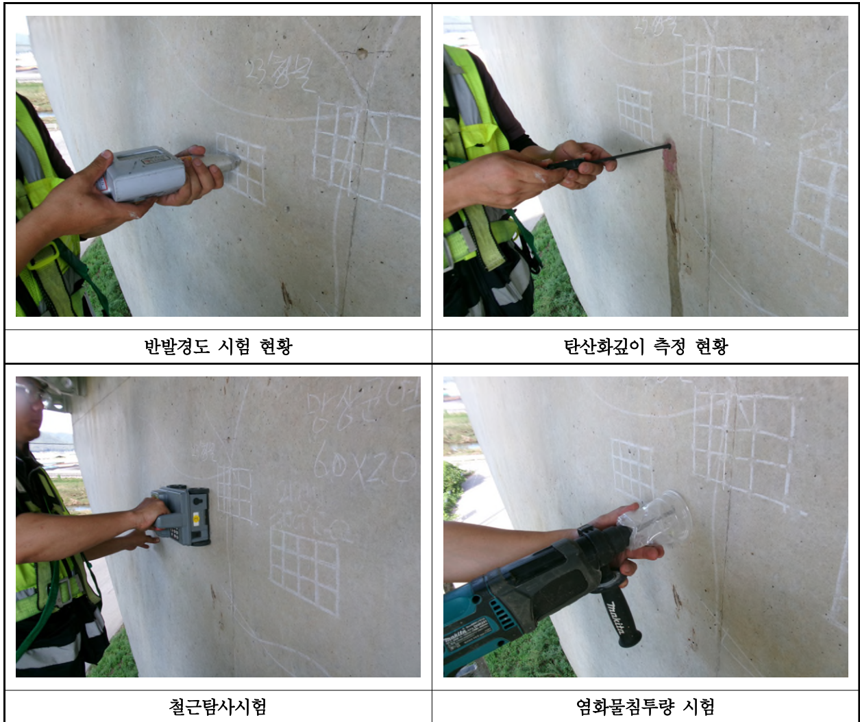
【사진 14.4.1】 콘크리트 내구성조사 현황
