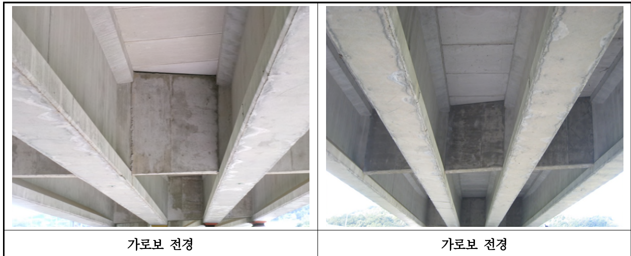
【사진 14.3.6】 가로보 전경
