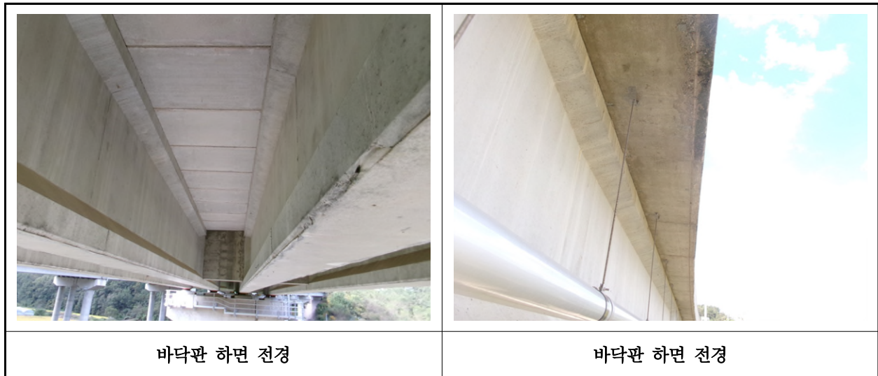
【사진 14.3.2】 바닥판하면 전경
