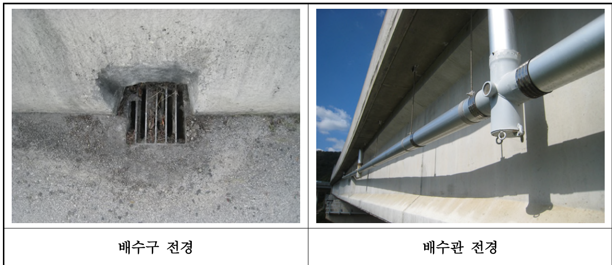
【사진 14.3.21】 배수시설 전경
