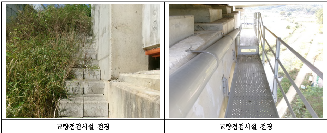
【사진 14.3.25】 교량 점검시설 전경
