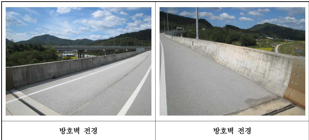
【사진 14.3.23】 방호벽 및 중앙분리대 전경
