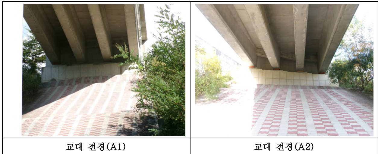
【사진 14.3.8】 교대 전경
