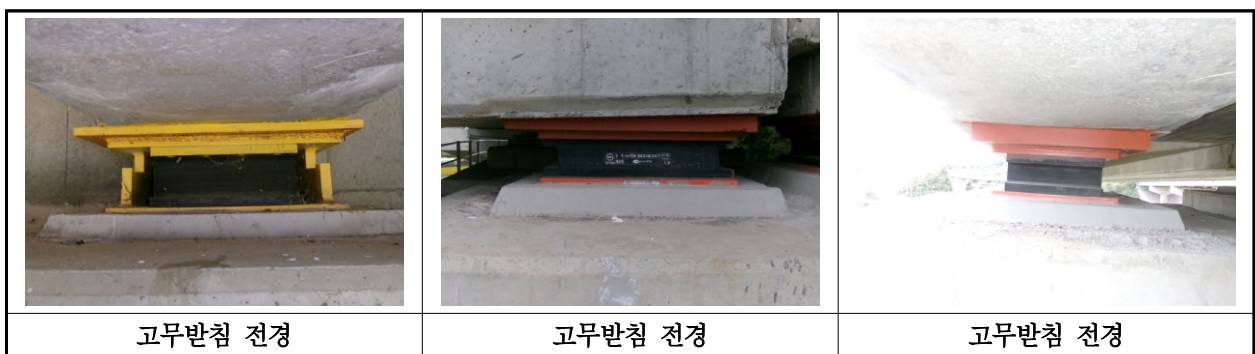
【사진 14.3.12】 교량반침 전경
